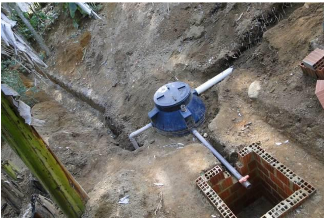
Figura 6: Instalação de um biodigestor em zona rural
